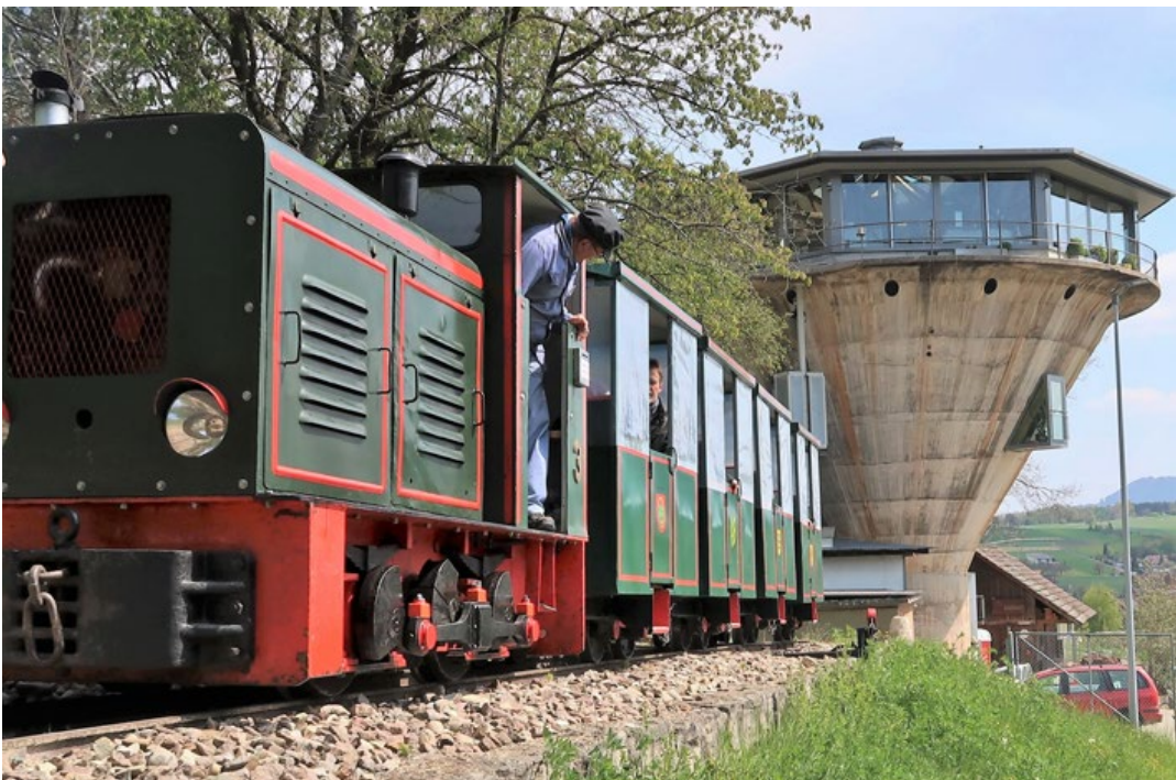
2 Das Bergwerksilo, im Jahr 1942 in Betrieb genommen, fasste einst 1000 Tonnen Eisenerz. Heute transportiert eine Lokomotive die Besucherinnen und Besucher vom Silo zum Stollen (Foto: Geri Hirt, Linn).
