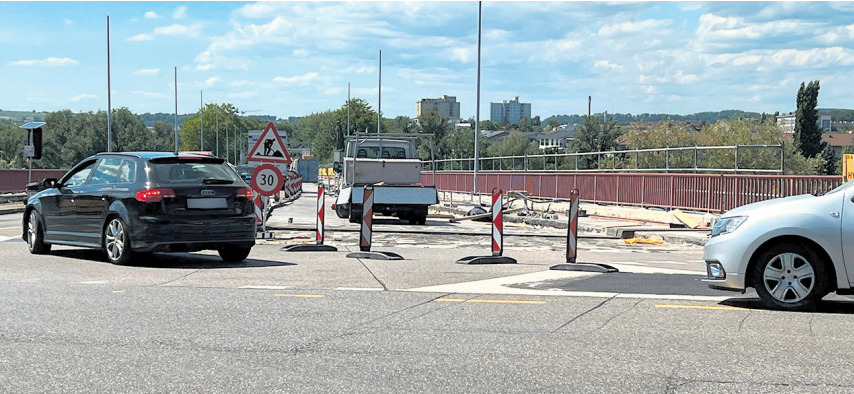
Die Sanierung der Fridolinsbrücke dauert bis Herbst 2023.
