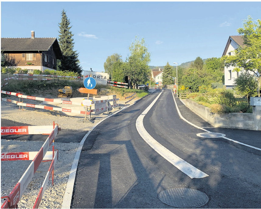
Der neue Strassenbelag.
