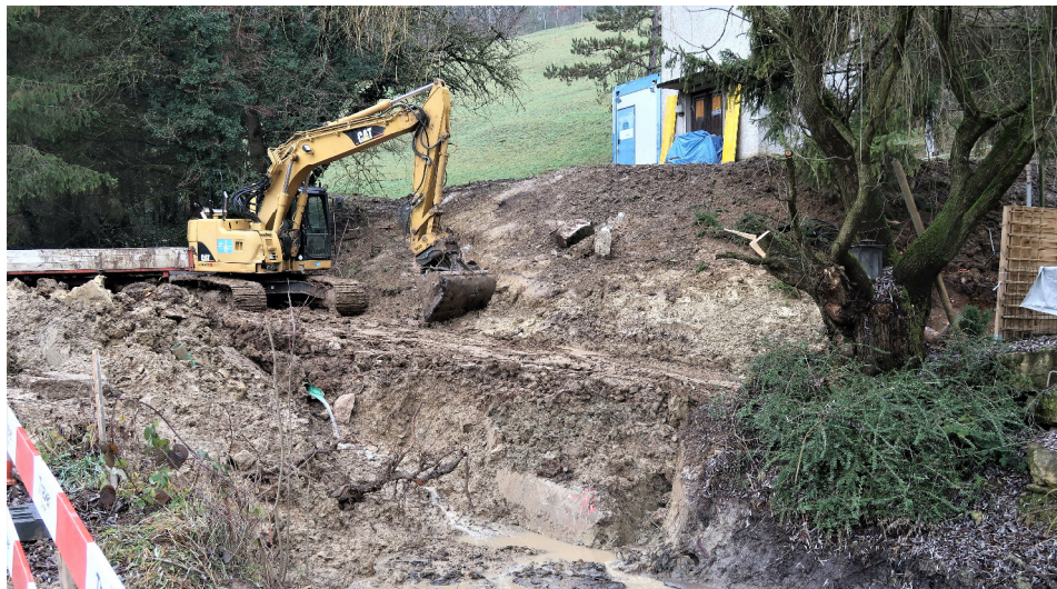
Das Gleis ist auf das ehemalige Höhenniveau abzusenken, was Grabarbeiten notwendig macht.
